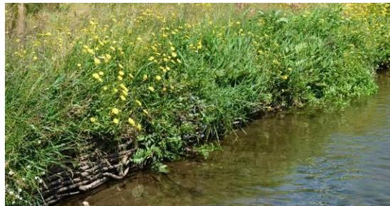
**Figura 6: Utilização de técnicas de engenharia natural para a estabilização de margens.**
